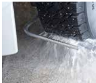
Impianto di lavaggio ruote con svolta dinamica
